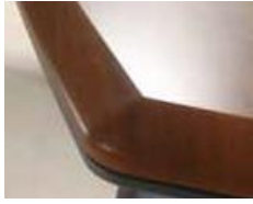
rys.2 Profilowanie krawędzi oraz łączenie płyt
